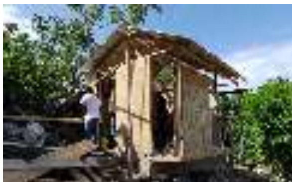
Fotografía 43 Construcción de la caseta en el Relleno Sanitario Blue Lizar
