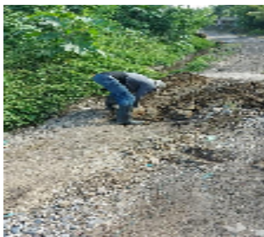
Fotografía 38 Adecuación puntual de vías de acceso al relleno.
