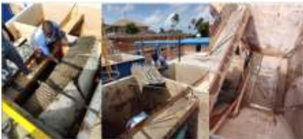
Fotografía 9 Retiro de placas de sedimentadores
