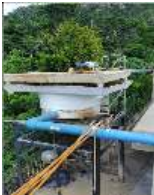
Fotografía 10 Bandeja de aireación en PTAP Agua Dulce
