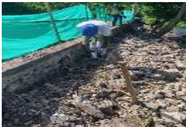
Fotografía 42 Proceso de demolición del muro de cerramiento en el Relleno Sanitario Blue Lizard
